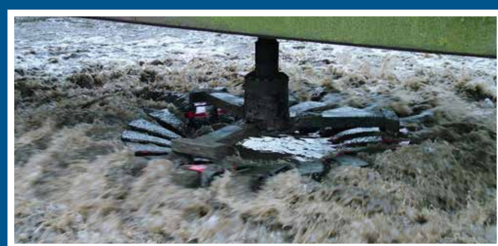
Aérateur de surface
