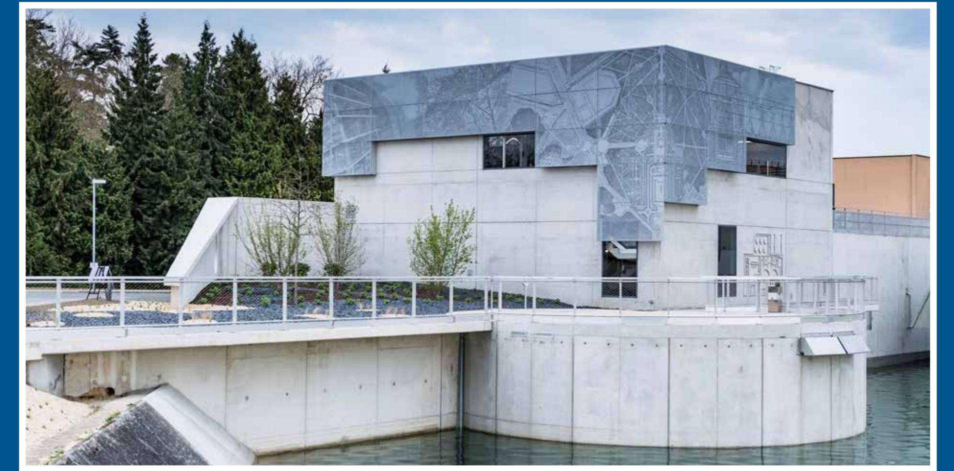
Usine de Louveciennes
