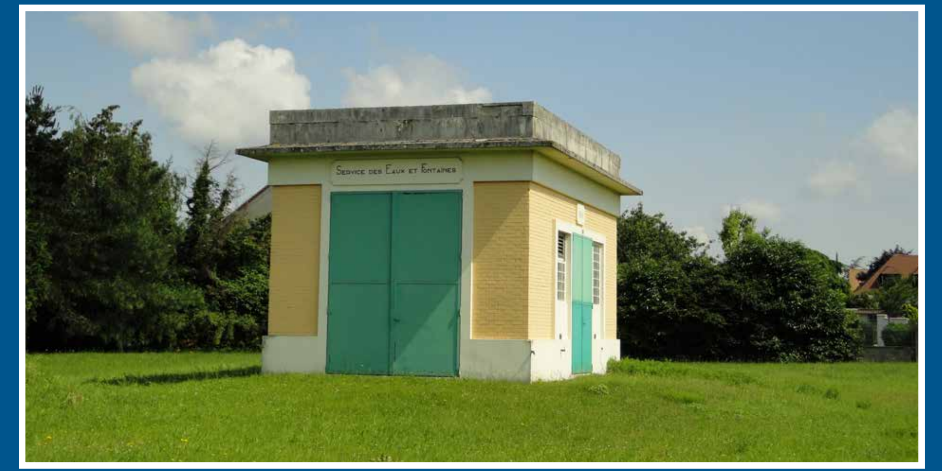
Station de forage de Croissy-sur-Seine
