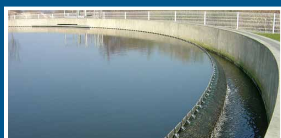
Clarificateur de la station d'épuration de Golbey, Vosges
